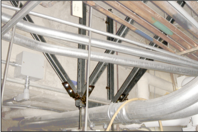
Şekil 3.7, 3.8, 3.9, 3.10 Elektrik Boruları ve Kablo Kanallarında Rijit Sistemler (Sismik Destekler) ile Deprem Koruması
