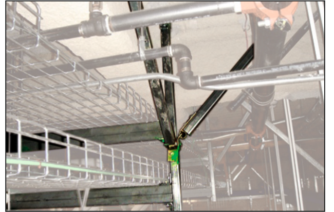
Şekil 3.7, 3.8, 3.9, 3.10 Elektrik Boruları ve Kablo Kanallarında Rijit Sistemler (Sismik Destekler) ile Deprem Koruması
